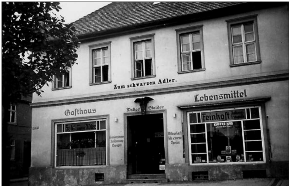
Hotel „Pod Czarnym Orłem”, ok. 1943. Markt 1 (Rynek). Budynek niezachowany (UM w Strzelcach Kraj.)
