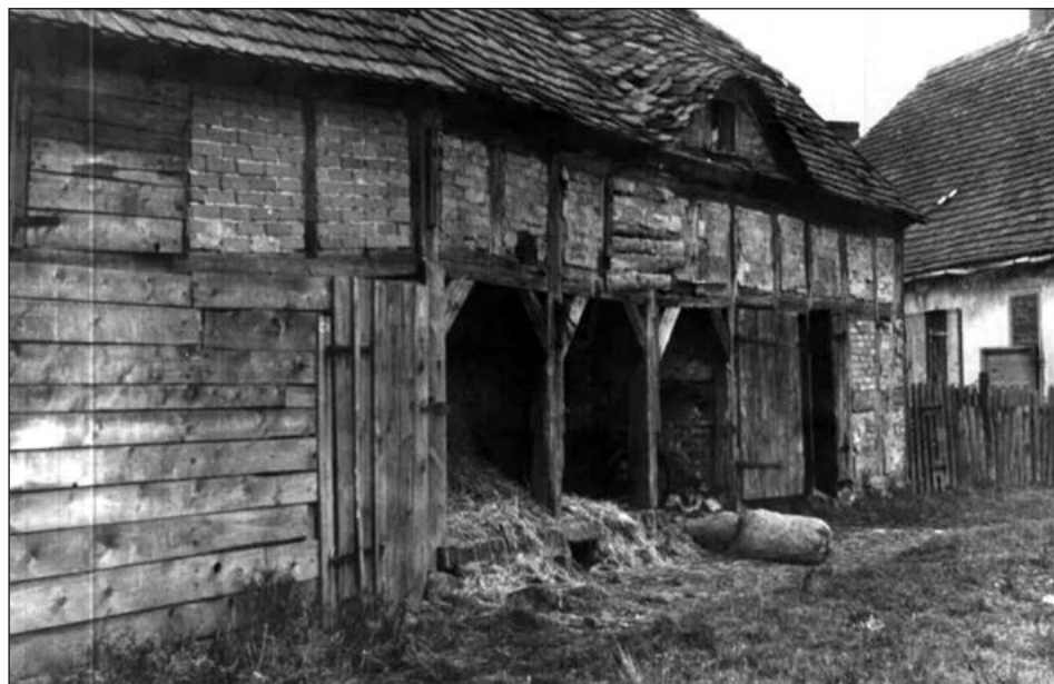
Podcienie budynku gospodarczego przy ul. Brygady Saperów 34, 1955. Obiekt niezachowany (Delegatura WUOZ w Gorzowie Wlkp.)
