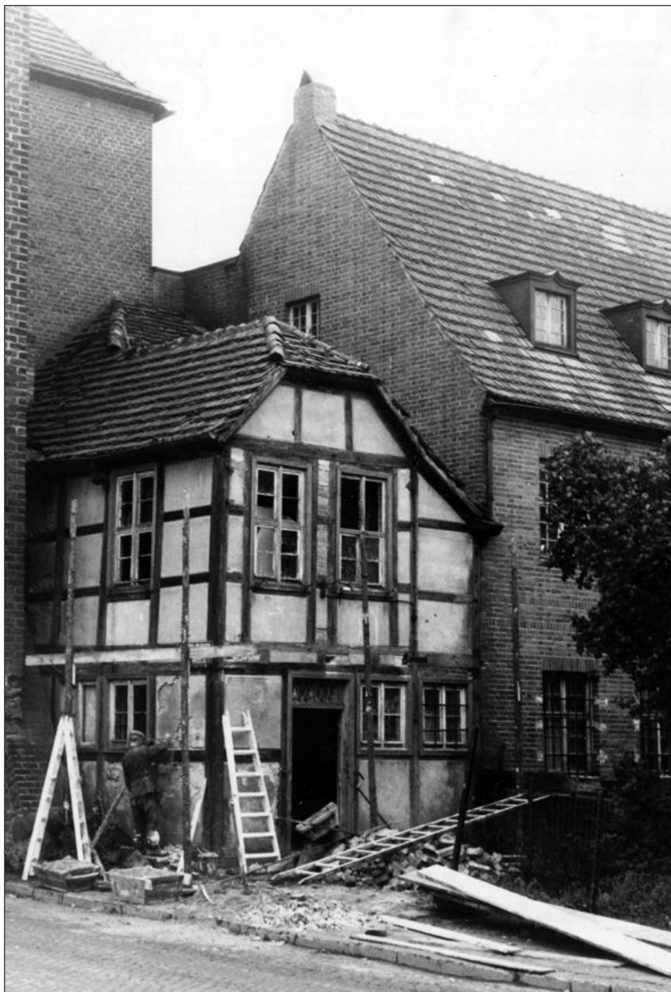
Budynek ryglowy przy Bramie Młyńskiej, 1960. Obiekt niezachowany (Delegatura WUOZ w Gorzowie Wlkp.)
