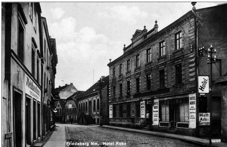
Hotel „Niemiecki Cesarz”, ok. 1930, Südumstraße 3 (ul. Południowa). Budynek niezachowany (UM w Strzelcach Kraj.)
