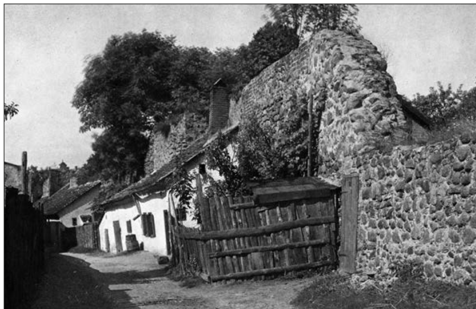
Mury miejskie i zabudowa przymurna, ok. 1913 (UM w Strzelcach Kraj.)
