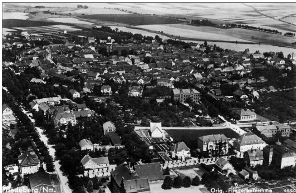
Widok z lotu ptaka w kierunku północno-wschodnim, ok. 1941 (UM w Strzelcach Kraj.)
