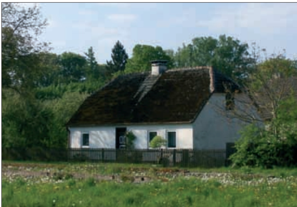
Budynek mieszkalny nr 29. Fot. M. Bidoł.
