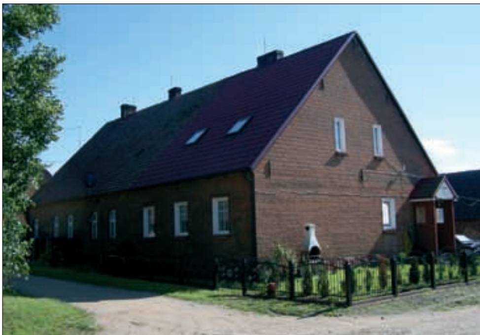
Budynek mieszkalny nr 23. Fot. M. Bidoł.
